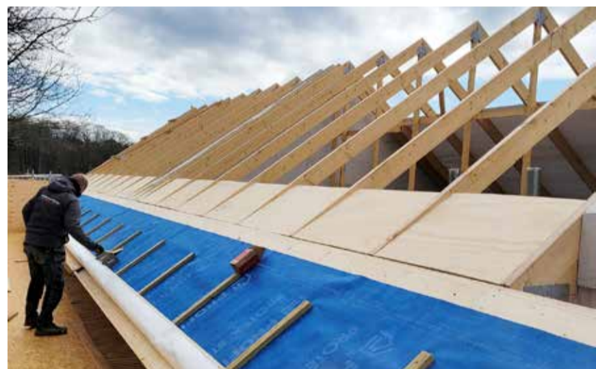
Entreprise på nybyg i Vejle
