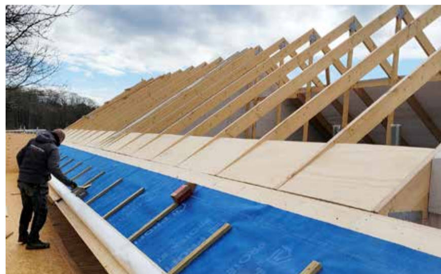
Entreprise på nybyg i Vejle
