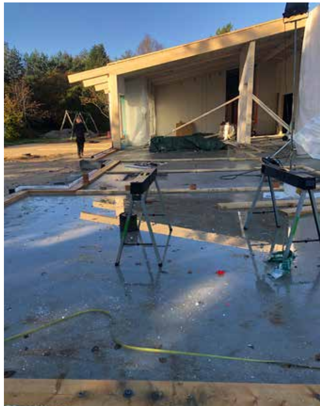
Da jeg var på besøg første gang, var man i gang med at fastgøre træprofiler til fundamentet.
