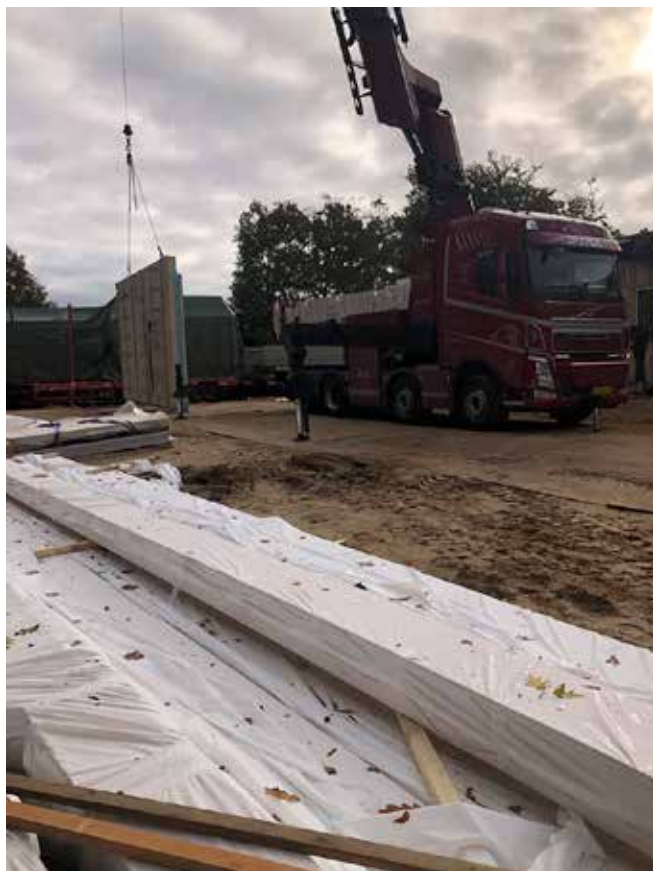
Elementer hejses på plads. Bemærk de lange limtræsspær der ligger i forgrunden.
