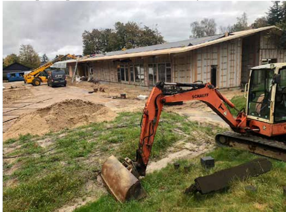
Byggeriet skrider fremad. Alt er nu overdækket, tagdækkene skal være færdige i denne uge og tømrerne går i gang med lofter.
