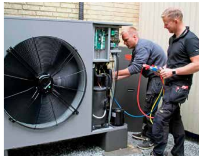
Igangsætning af én af de større varmepumper.
